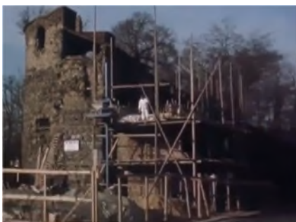
Abb. Wiederaufbau des Sachsenenturms (1971)
